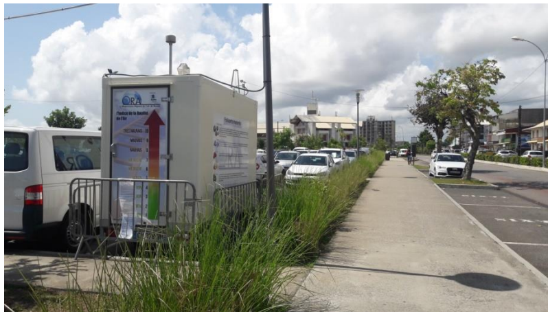
Figure 1 : Photo de la station INDY sur le parking du boulevard Mandela
