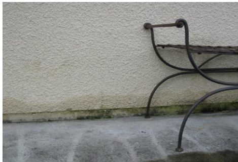
Front d'eau visible sur la face extérieure d'un mur et contaminations résultantes dans la chambre d'enfant attenante. Cause : Remontées capillaires
